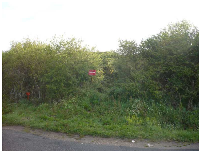
Clôture et panneaux en limite de carrière
