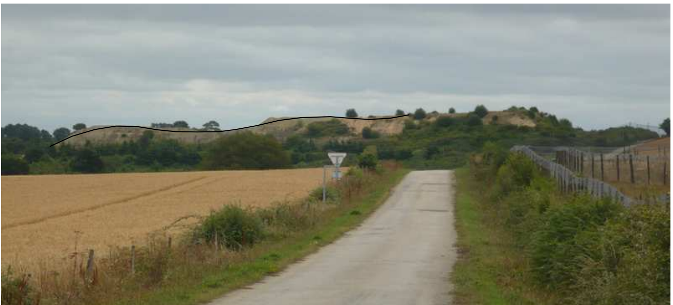
Re-profilage du sommet du stock de stériles Nord
